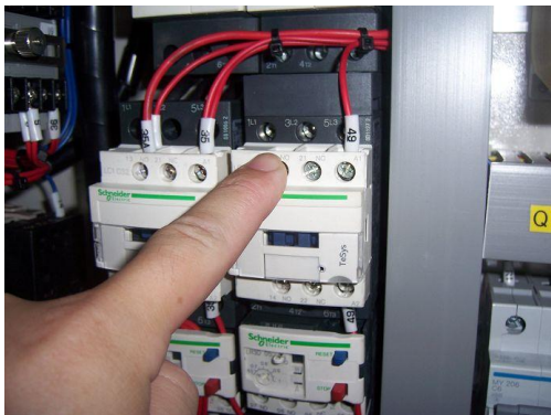
(樣板) 電磁接觸器 IP2X 防手觸電
