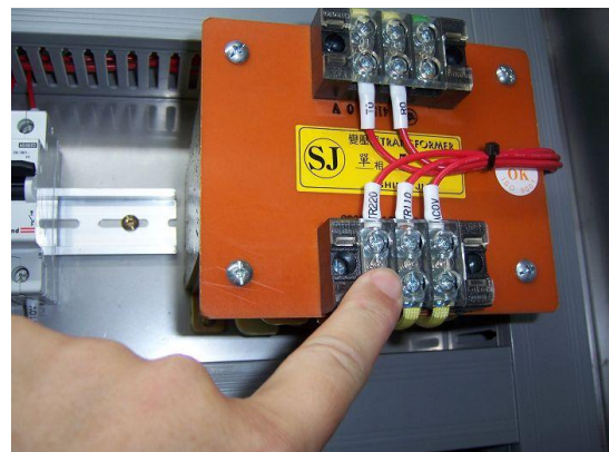
(樣板) 變壓器 IP2X 防手觸電
